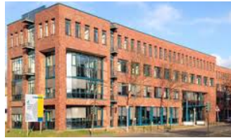
Wartung und Reparatur von Sonnenschutzanlagen
